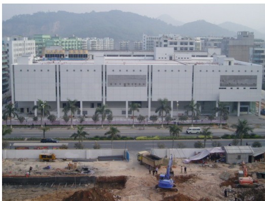
2003年，印力第一个项目“深国投宝安购物广场”破土动工
